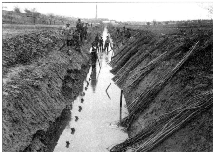
A futóhomok miatt a partoldal több helyen is beomlott, ezért rőzsefonási munkálatokat is végeztek
