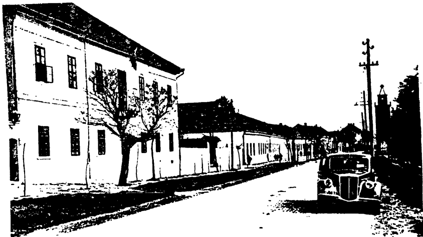
3. Az 1805-ben épült bárói kastély. Mellette a zárdaiskola. A kastély erkélye alatti kapubejáratot az 1930-as években befalazták.
