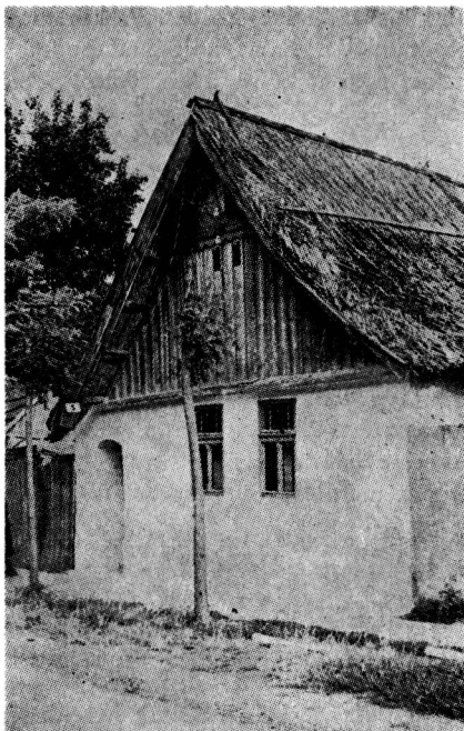
Náddal fedett, faoromzatos, döngölt földű népi építészeti emlék
