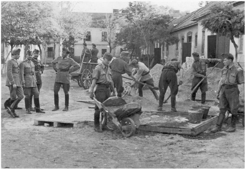
Katonák betont kevernek a zombori laktanyában 1941. április 30-án (Magángyűjtemény)
