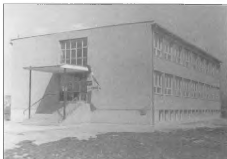
Az új iskolaépület 1965-ben épült
