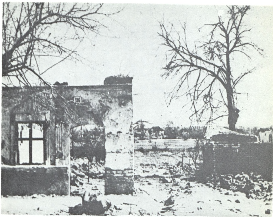
Deo porušene železničke stanice u Batini
