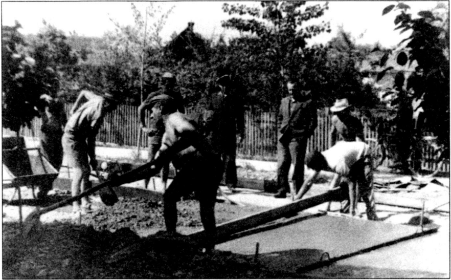
A kubikolás utolsó állomása. Betonozzák a kishegyesi Vasút utcát 1971-ben
