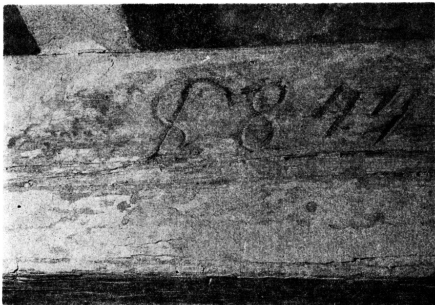
Az építés idejét bevészték a mestergerendába
