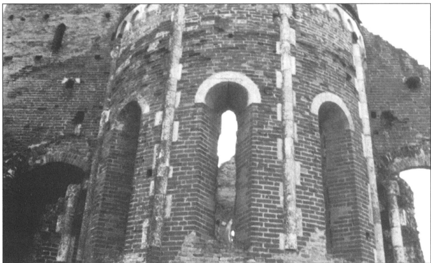
6. kép: A keleti homlokzat részlete a mellékapszisos tetőzetének a csücsát jelző köelemekkel
