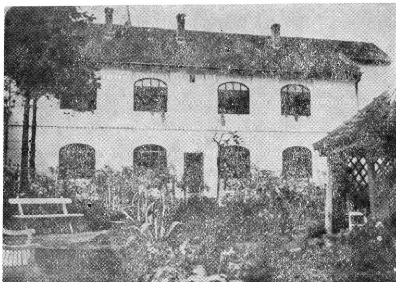
4. Az 1885-ben épült zárdaiskolai lakószárny
